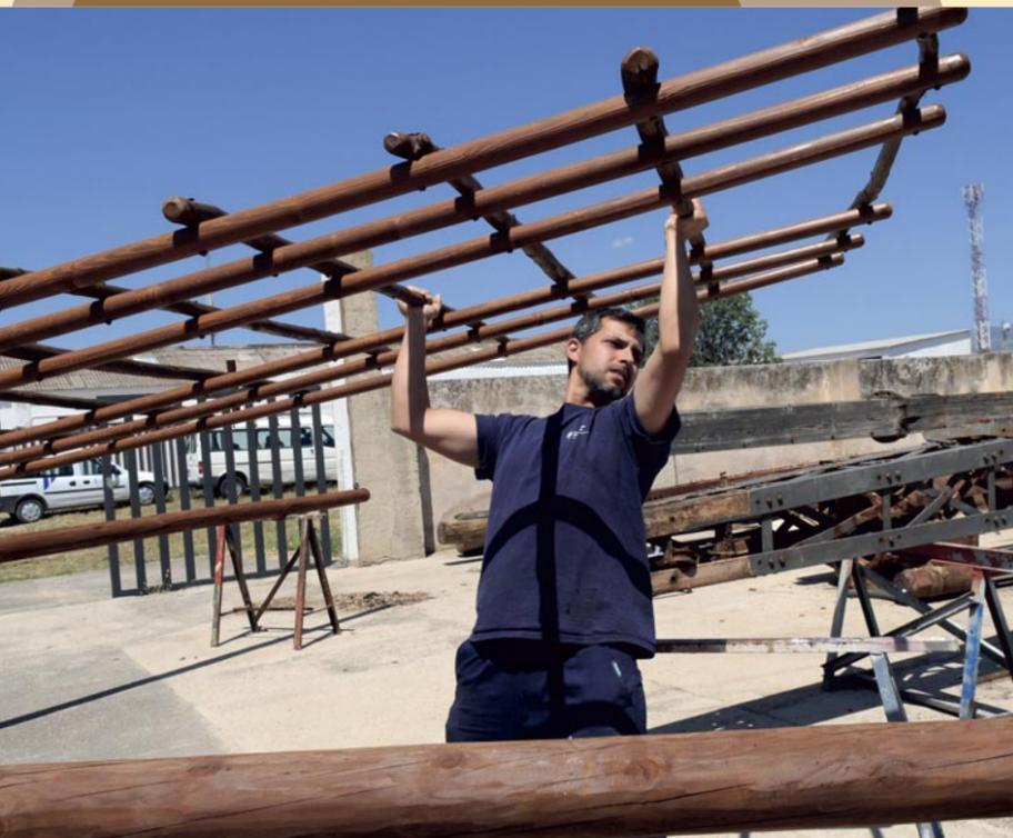
■ Эта металлоконструкция скоро станет крыльями ветряка.
